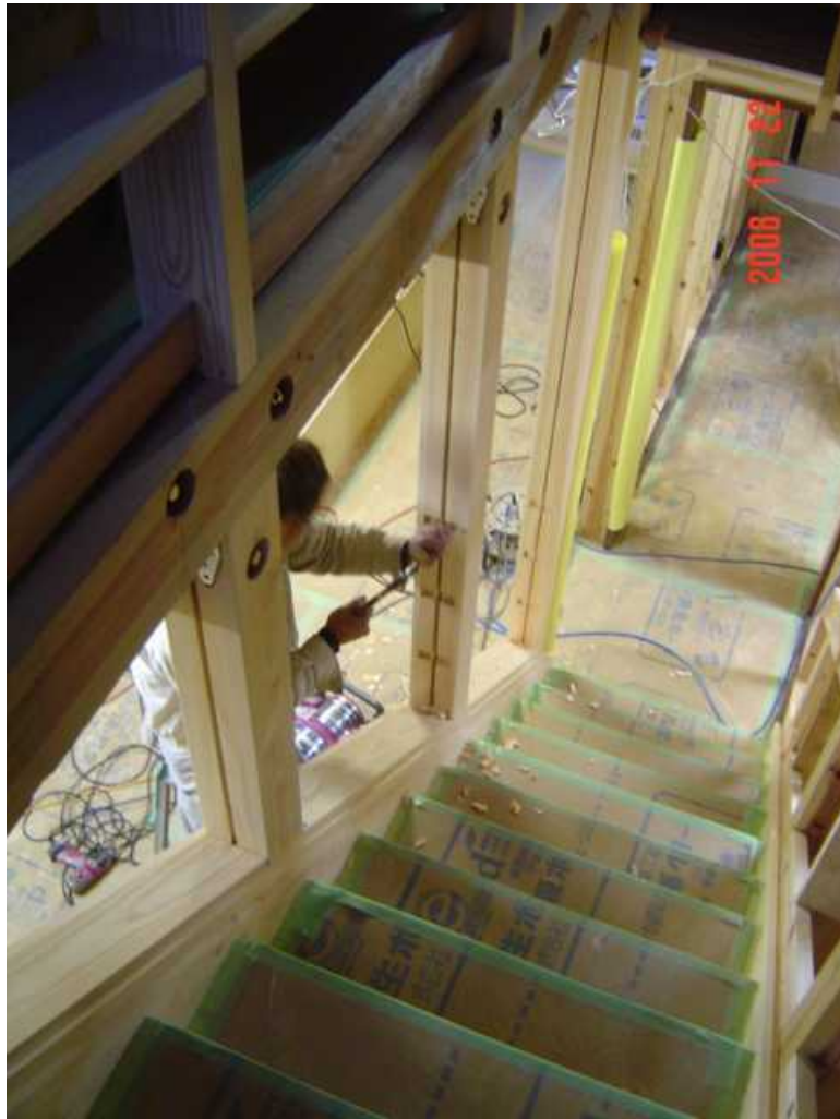
55 階段手すり工事中
